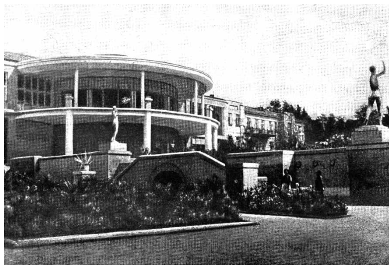
Фото 4. Санаторий Центрального комитета профсоюза работников связи, г. Кисловодск. Архитектор М.И. Гинцбург. 1935 г. Фотодокумент. 10,5 × 15,5 см. РГА в г. Самаре. Ф. Р-150. Оп. 1-1. Д. 85. Л. 57
